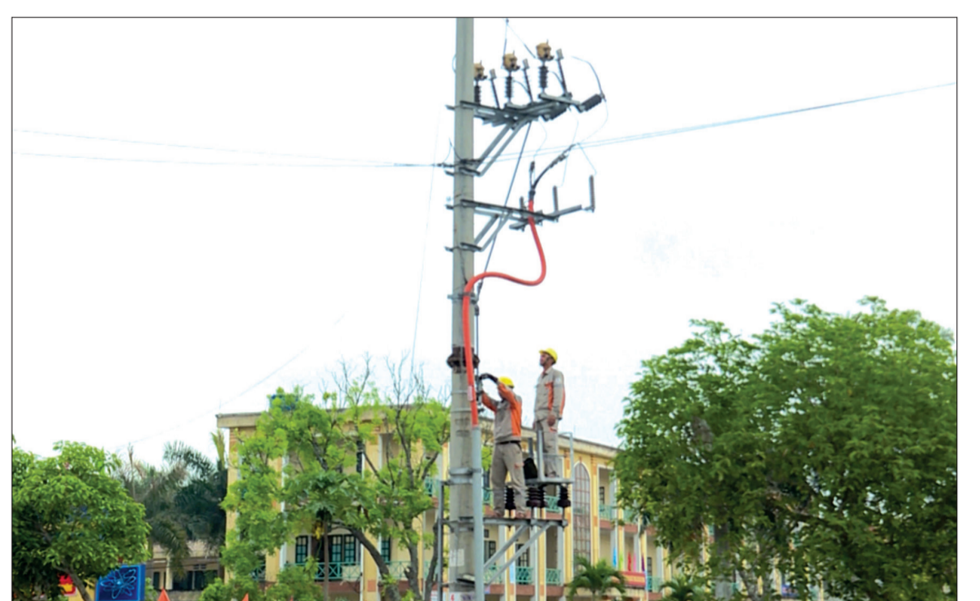
Kiểm tra, sửa chữa trạm biến áp bảo đảm cung cấp điện an toàn, ổn định trong mùa mưa bão.
