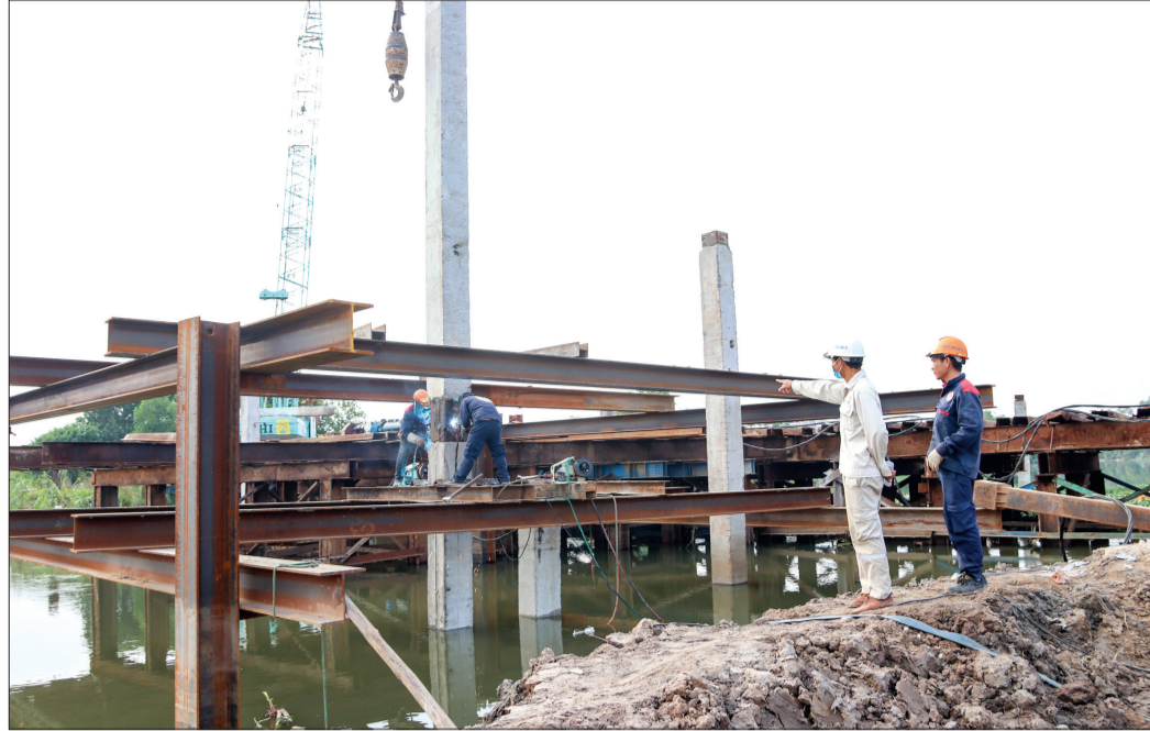
Tuyến đường vành đai phía Nam thành phố Thái Bình, đoạn từ cầu ngang S1 đến đường Chu Văn An kéo dài được thẩm định, giám sát chặt chẽ về chất lượng thi công.
