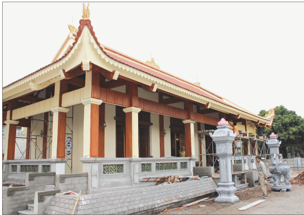
Công trình nhà tưởng niệm tại Khu lưu niệm đồng chí Nguyễn Đức Cảnh.
