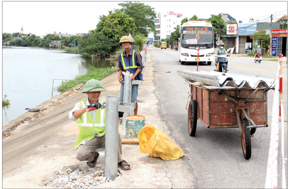
Lắp đặt bổ sung tôn hộ lan tại đường tỉnh ĐT.458, đoạn qua địa phận xã Hòa Bình (Kiến Xương).
