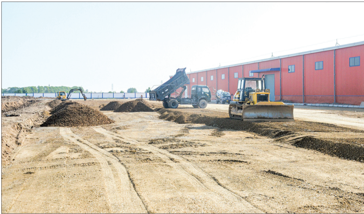
Cụm công nghiệp Quý Ninh giai đoạn 2 phần đầu hoàn thiện hạ tầng trong năm 2024.
