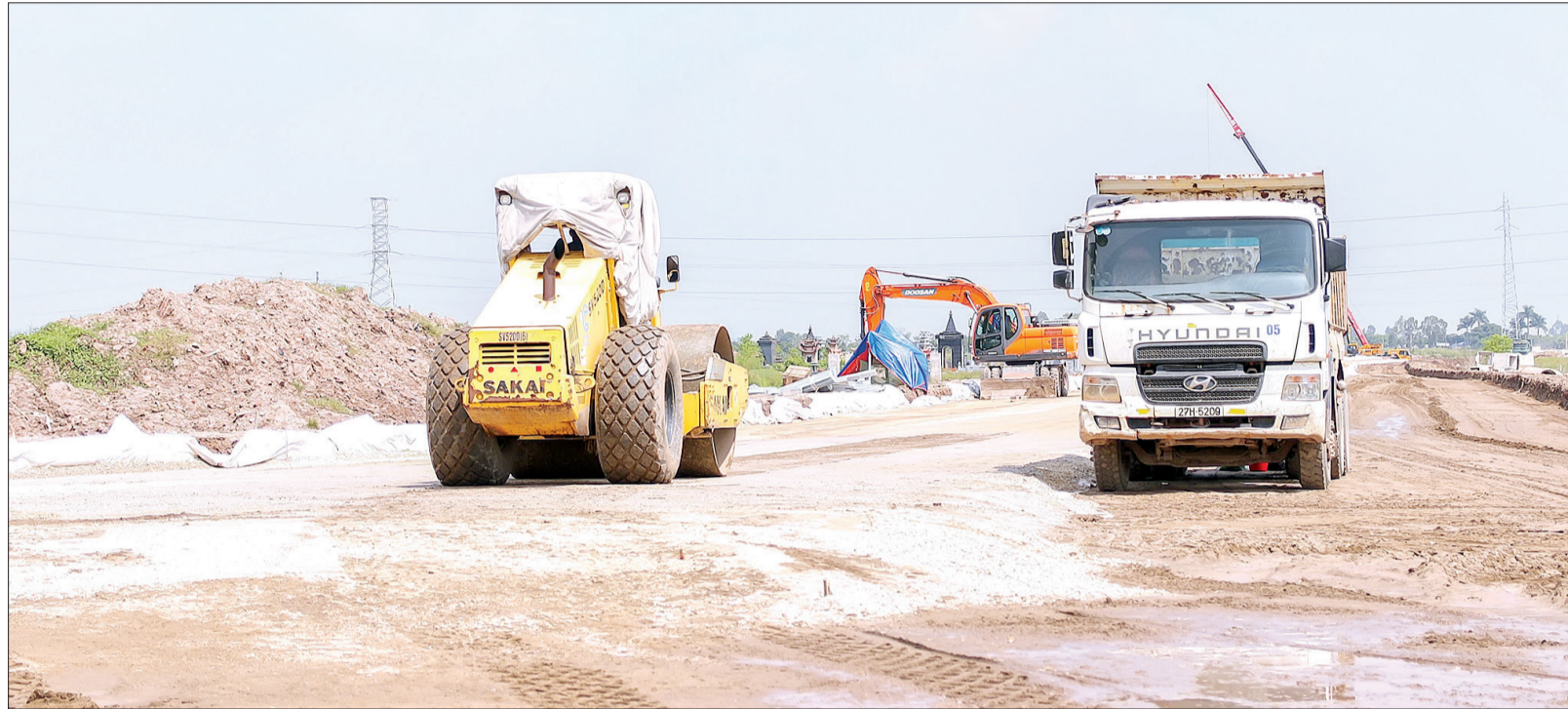
Thi công tuyến đường bộ ven biển đoạn qua địa bàn huyện Thái Thụy sau khi người dân đồng thuận bàn giao mặt bằng.
