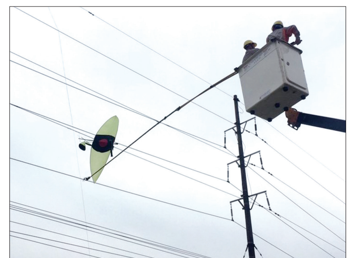
Công nhân Công ty Điện lực Thái Bình khắc phục sự cố do diều vướng vào lưới điện.
