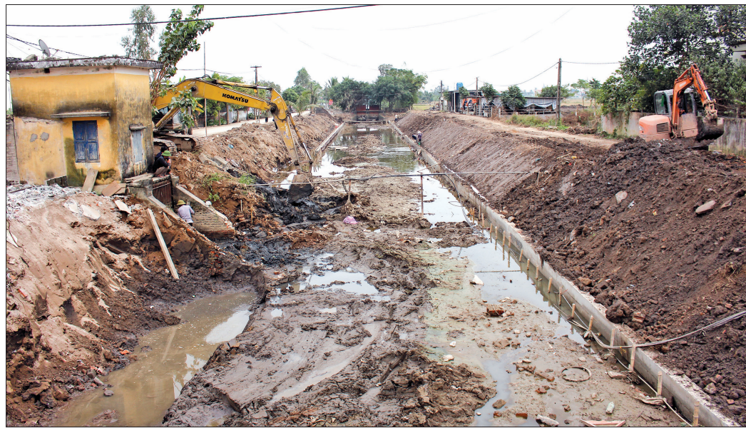
Thi công dự án nạo vét và gia cố mái bờ sông N2 huyện Thái Thụy.
