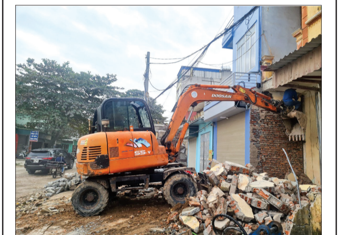
Đẩy nhanh tiến độ giải phóng mặt bằng dự án đường thành phố Thái Bình đến cầu Sa Cao.
