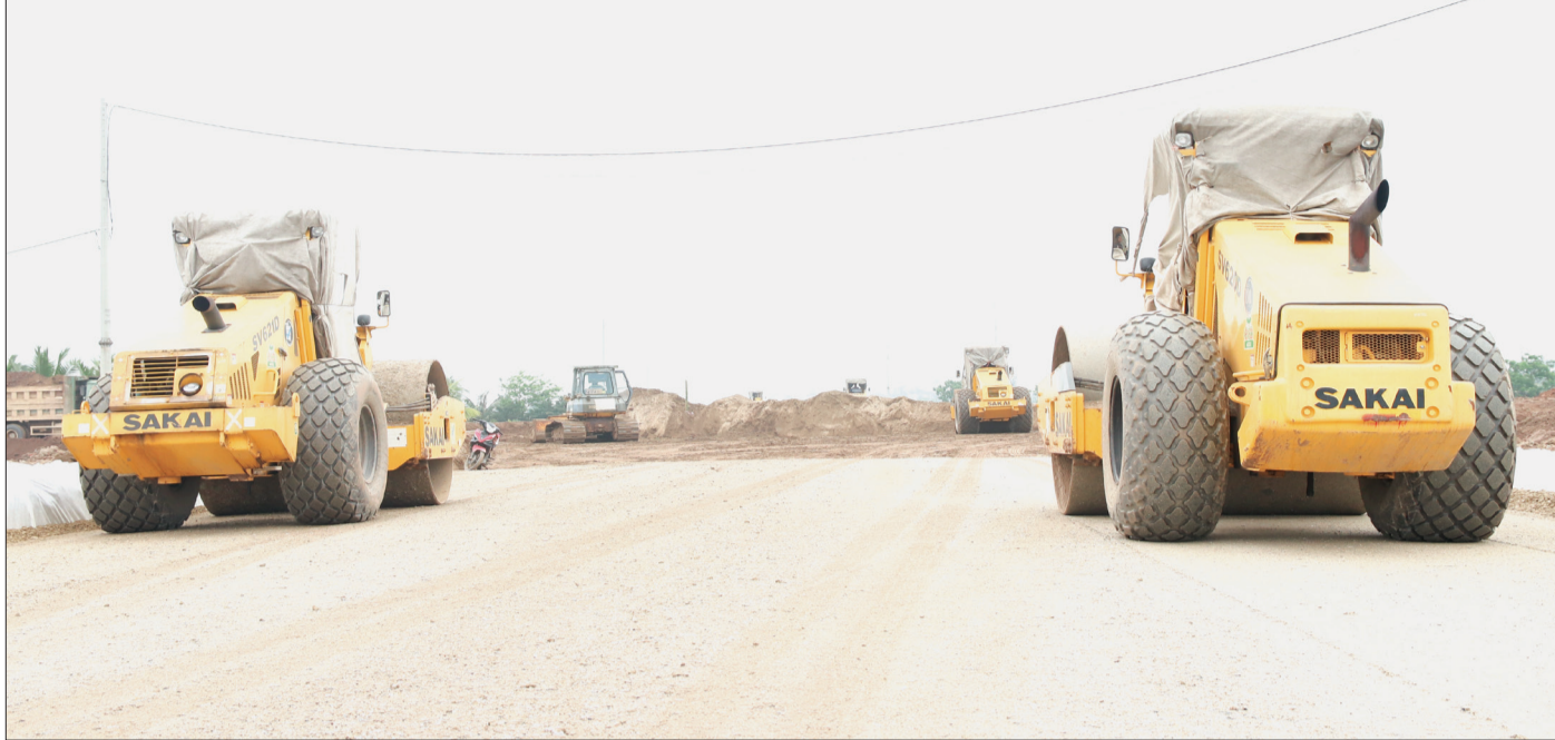
Thi công tuyến đường bộ ven biển đoạn qua địa phận xã Thái Đô (Thái Thụy).
