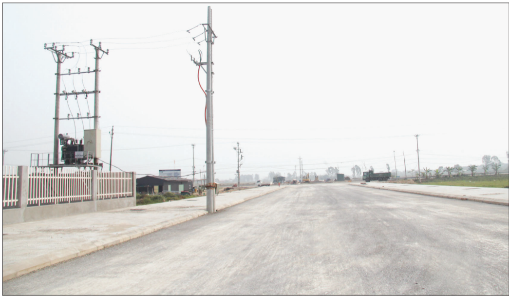
Cơ sở hạ tầng cụm công nghiệp Thống Nhất.
