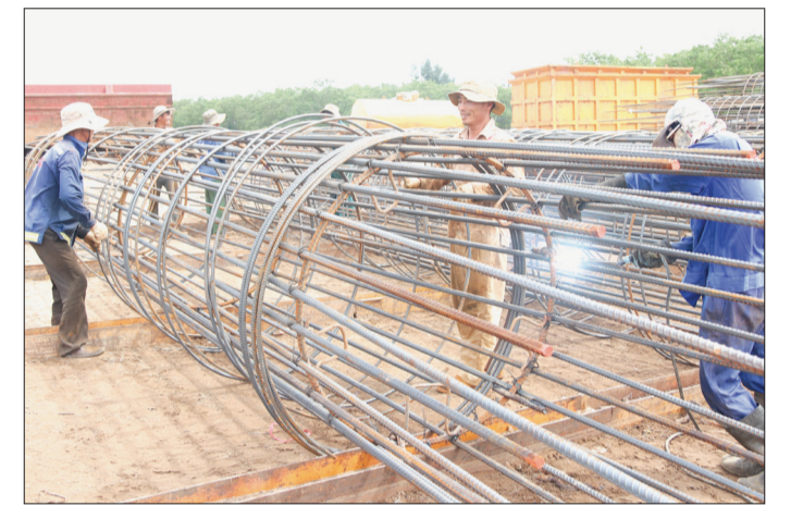
Thi công cầu sông Hồng thuộc dự án tuyến đường bộ ven biển.
