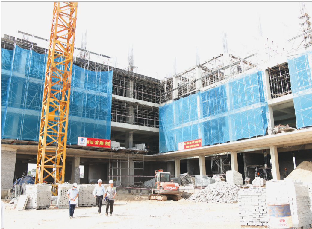
Công trình tòa nhà Trung tâm Kiểm soát bệnh tật tỉnh là một trong những công trình trọng điểm đang được quan tâm đẩy nhanh tiến độ.
