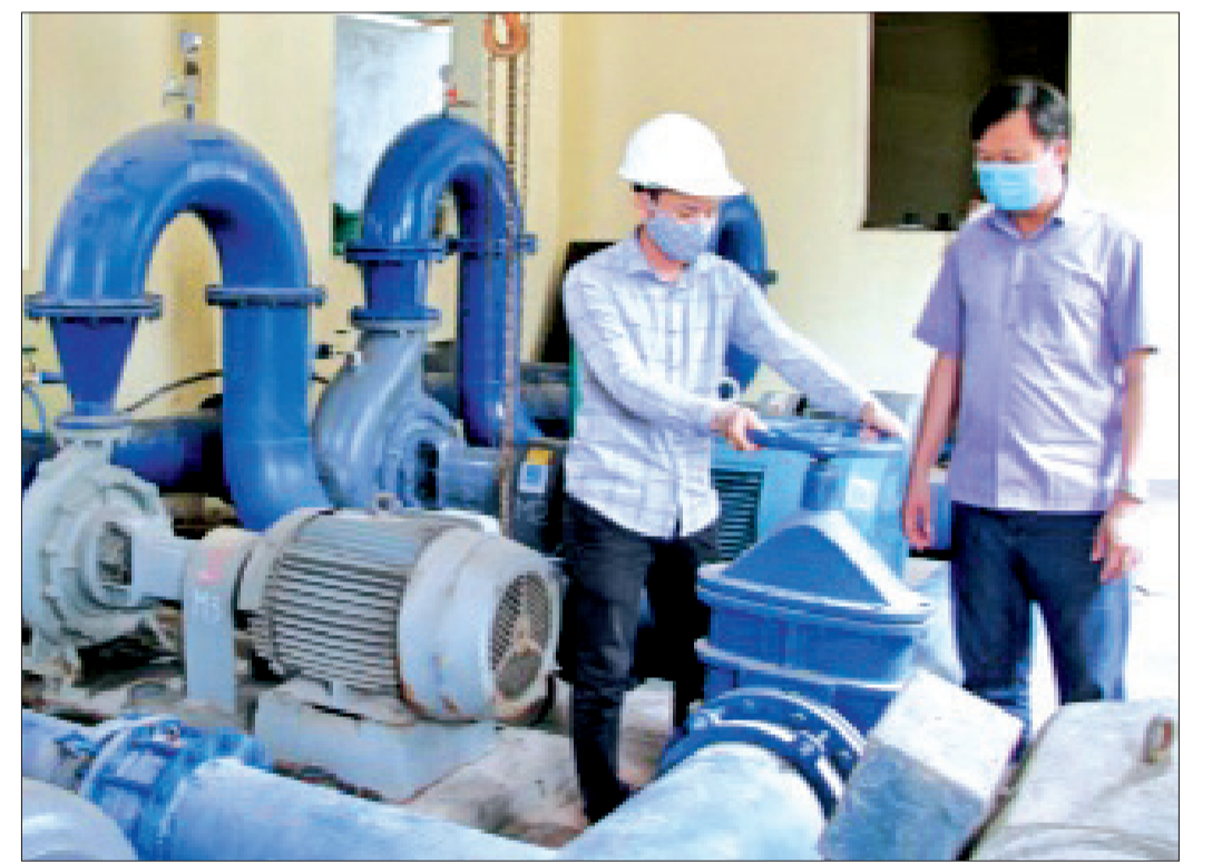
Kiểm tra hệ thống cấp nước tại nhà máy nước sạch Quỳnh Giao (Quỳnh Phụ).
