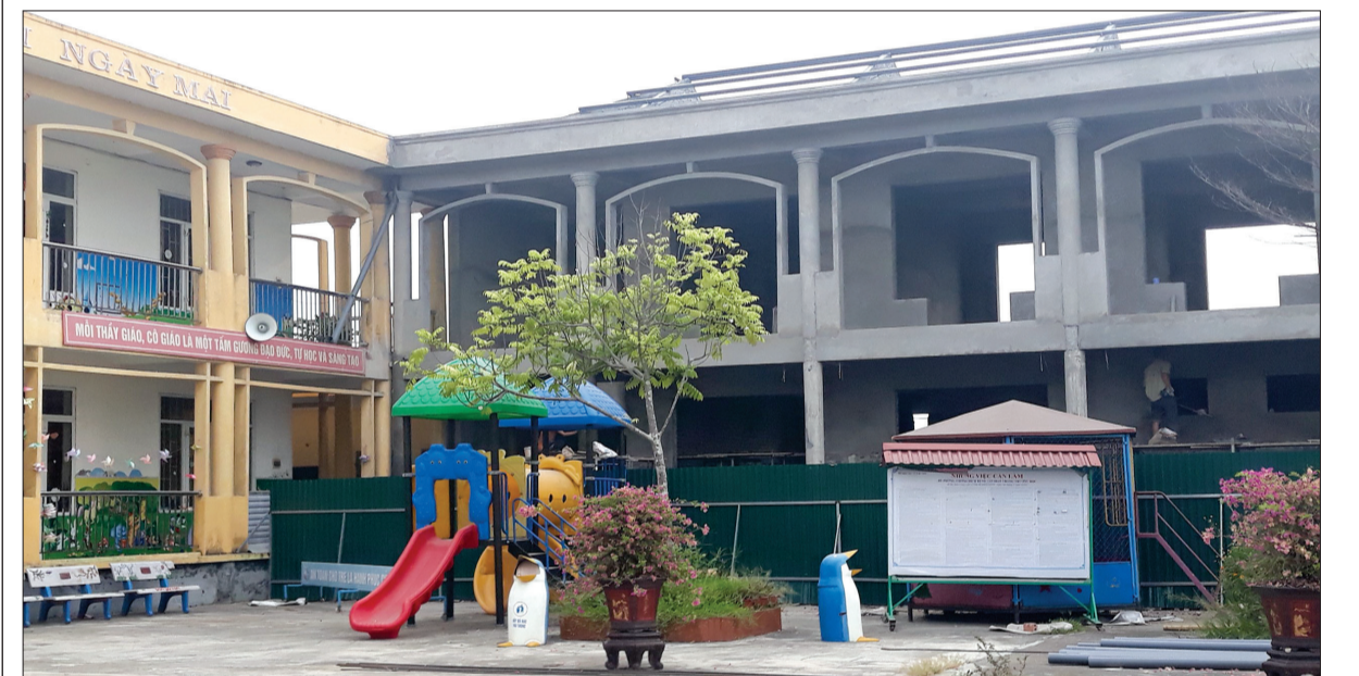
Công trình dãy phòng học 2 tầng Trường Mầm non Thái Thuận, xã Thuận Thành (Thái Thụy) đang được khẩn trương hoàn thiện trước thêm năm học mới.
