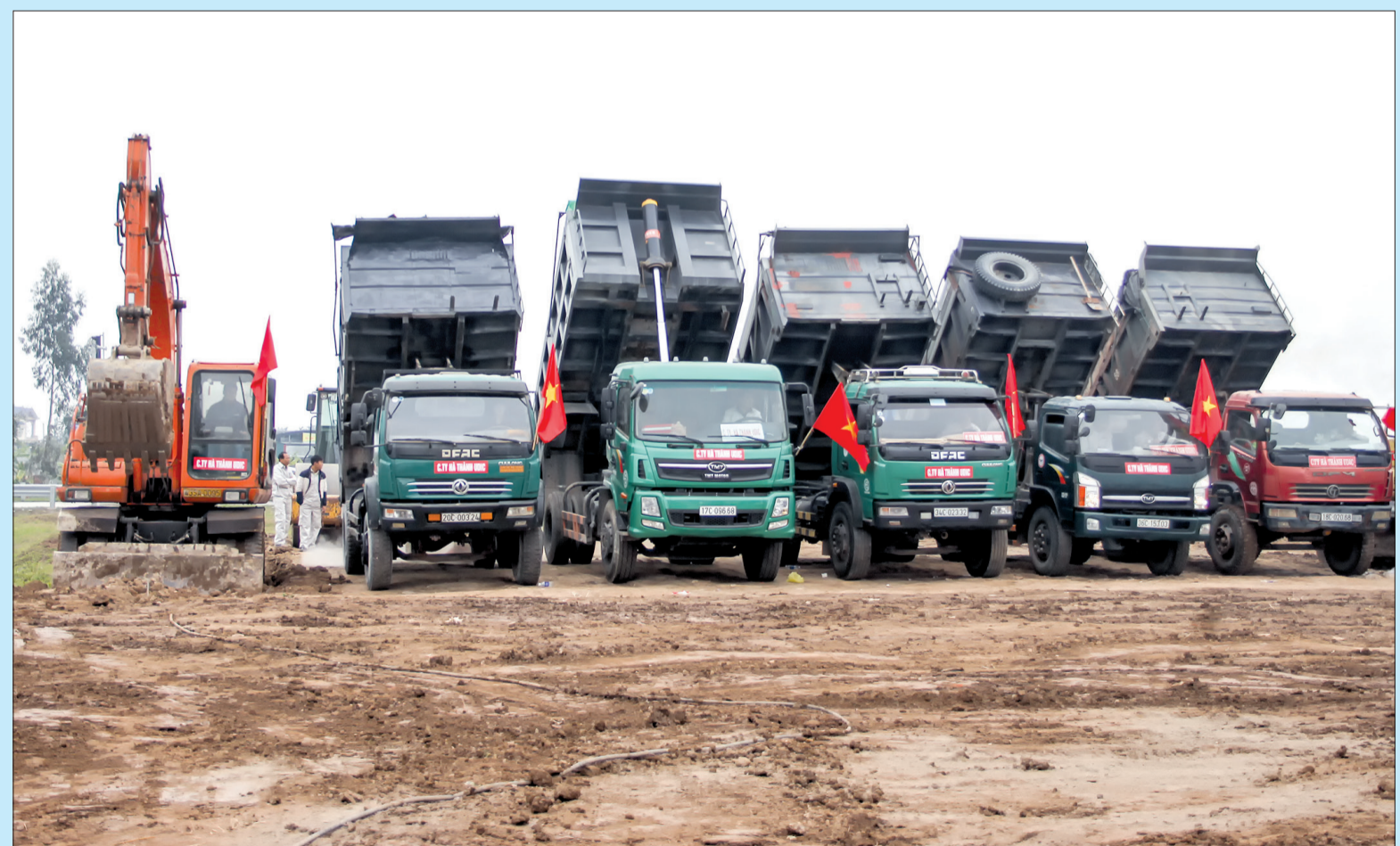
Đơn vị thi công sẵn sàng phương tiện, máy móc để đẩy nhanh tiến độ dự án.
