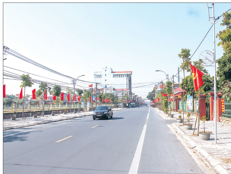
Tính lộ 456 đoạn qua xã Thụy Phong (Thái Thụy) được lắp đặt hệ thống đèn chiếu sáng từ nguồn xã hội hóa.
