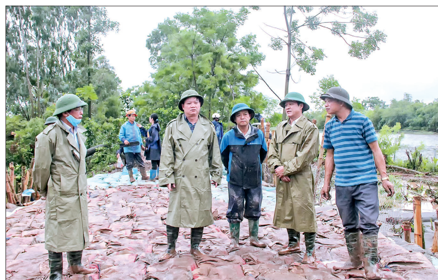
Đồng chí Nguyễn Khắc Thân, Tỉnh ủy viên, Phó Chủ tịch UBND tỉnh kiểm tra công tác xử lý sự cố sạt lở bờ bao khu nuôi trồng thủy sản xã An Ninh (Quỳnh Phụ).
