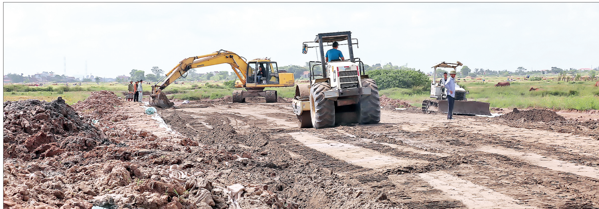
Dự án tuyến đường bộ ven biển đoạn xã Thụy Tân (Thái Thụy) đang thi công.
