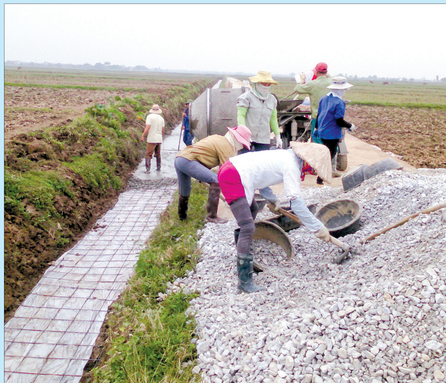
Xã Thụy Chính (Thái Thụy) đầu tư xây dựng hệ thống thủy lợi nội đồng.
