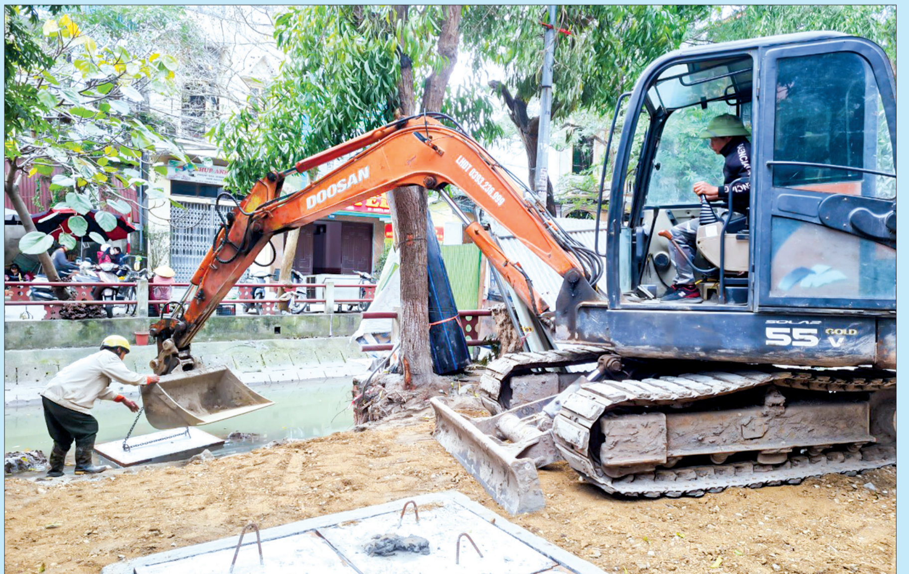
Thi công tại cầu Máy Miến.
