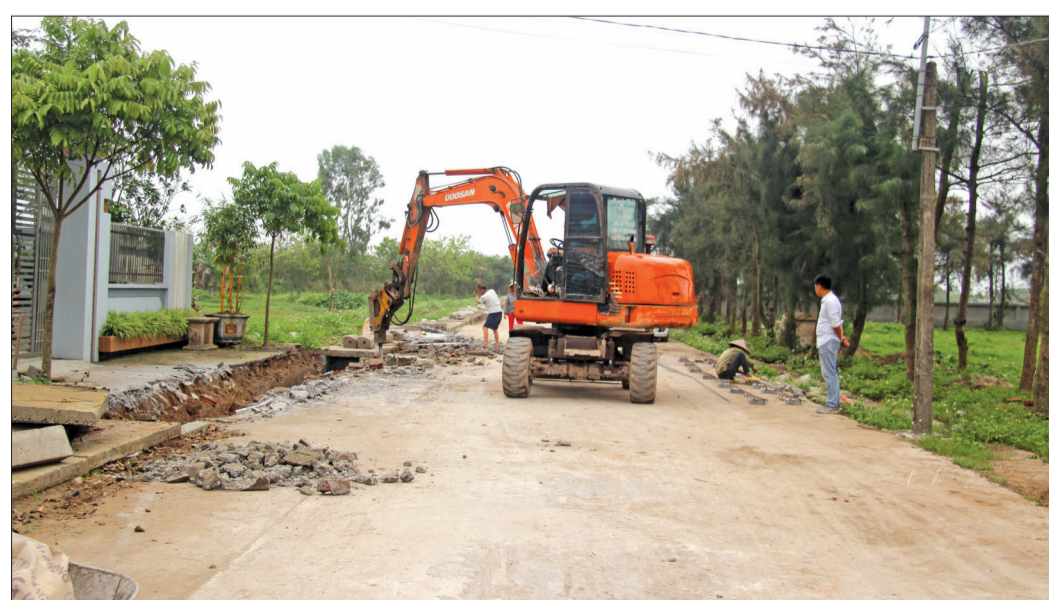
Hệ thống thoát nước tại một số tuyến đường trục thôn ở xã Vũ Lăng đang được gấp rút hoàn thiện.
