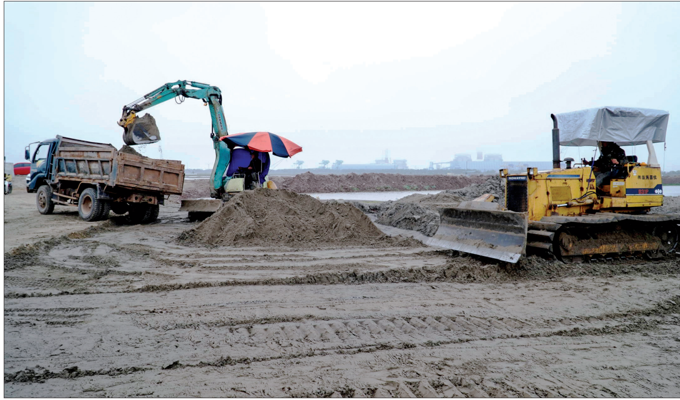
Nhà đầu tư hạ tầng khu công nghiệp Hải Long huy động nhân lực, phương tiện tổ chức san lấp mặt bằng diện tích được bàn giao.
