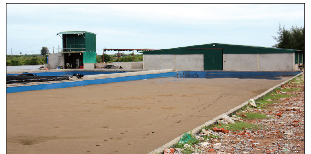
Khu vực chủ đầm xây dựng công trình trong hành lang bảo vệ đê biển số 5 tại thôn Thiện Tường, xã Nam Thịnh (Tiền Hải).
