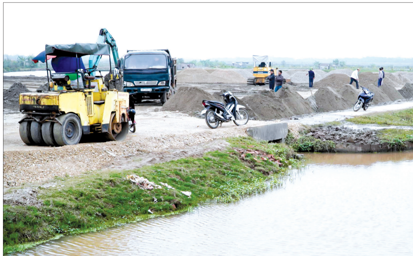
Nhà đầu tư hạ tầng khu công nghiệp Hải Long triển khai san lấp mặt bằng chuẩn bị tổ chức lễ khởi công động thổ dự án.
