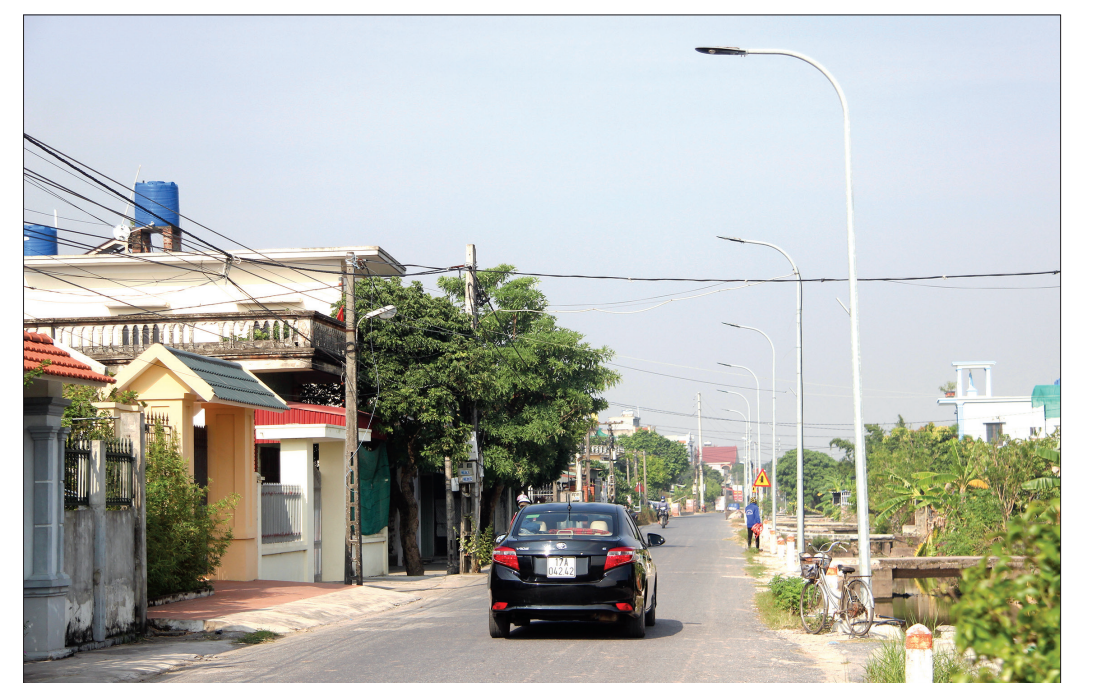
Hệ thống điện chiếu sáng các tuyến đường tại xã Bắc Hải.
