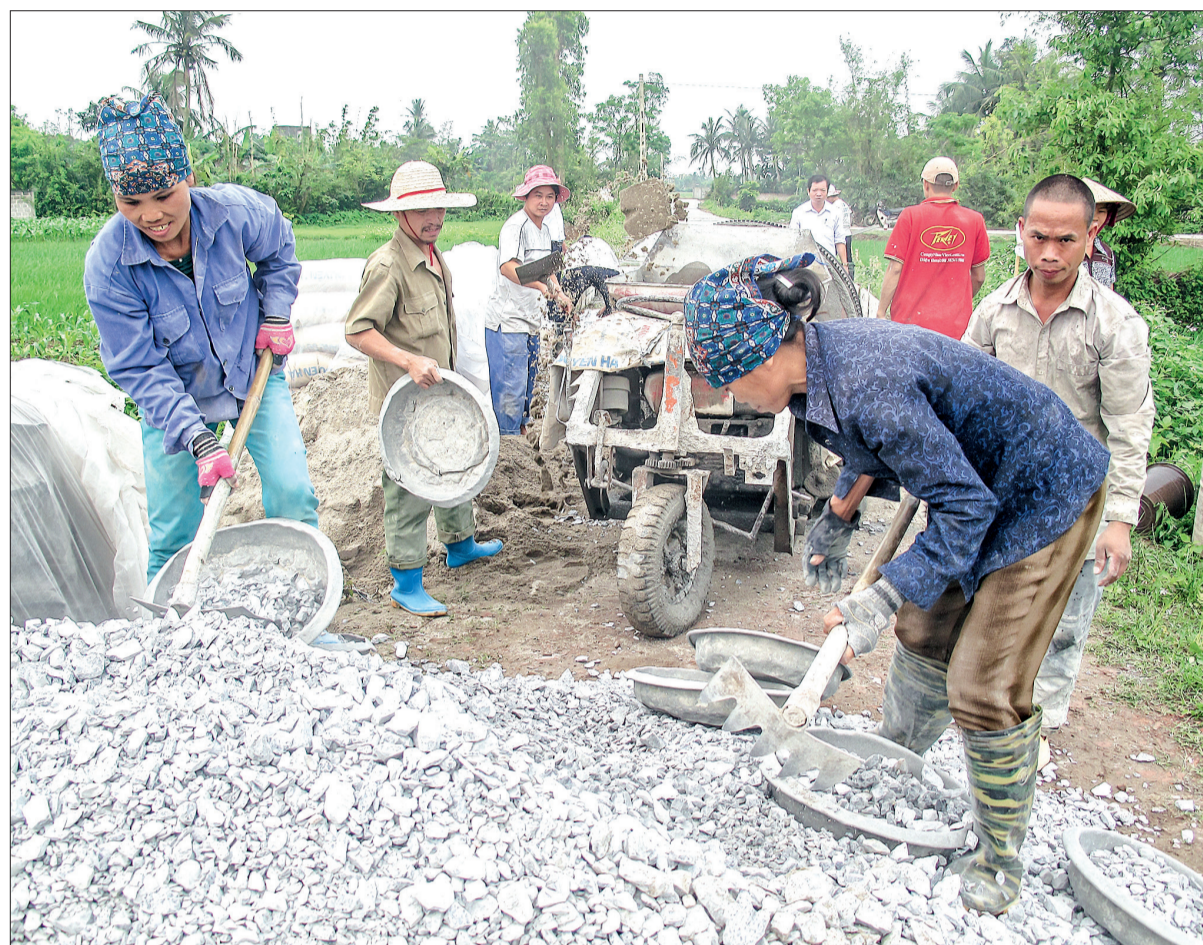
Xây dựng nông thôn mới ở xã Thái Tân (Thái Thụy).
