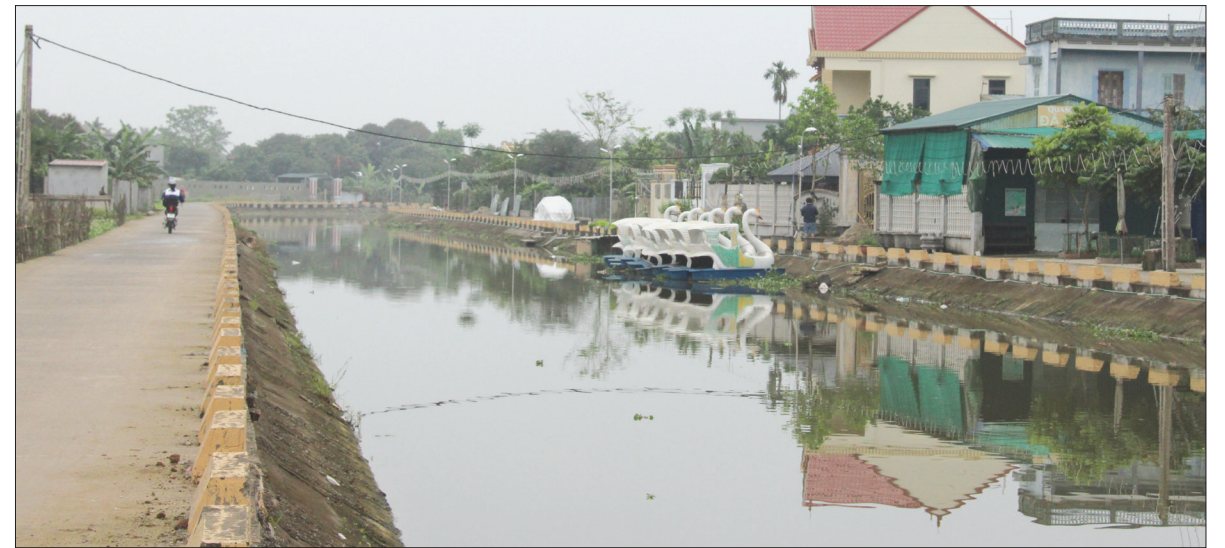
Con đường và sông Thống Nhất được bê tông, kè chắn tạo cảnh quan sạch đẹp.
