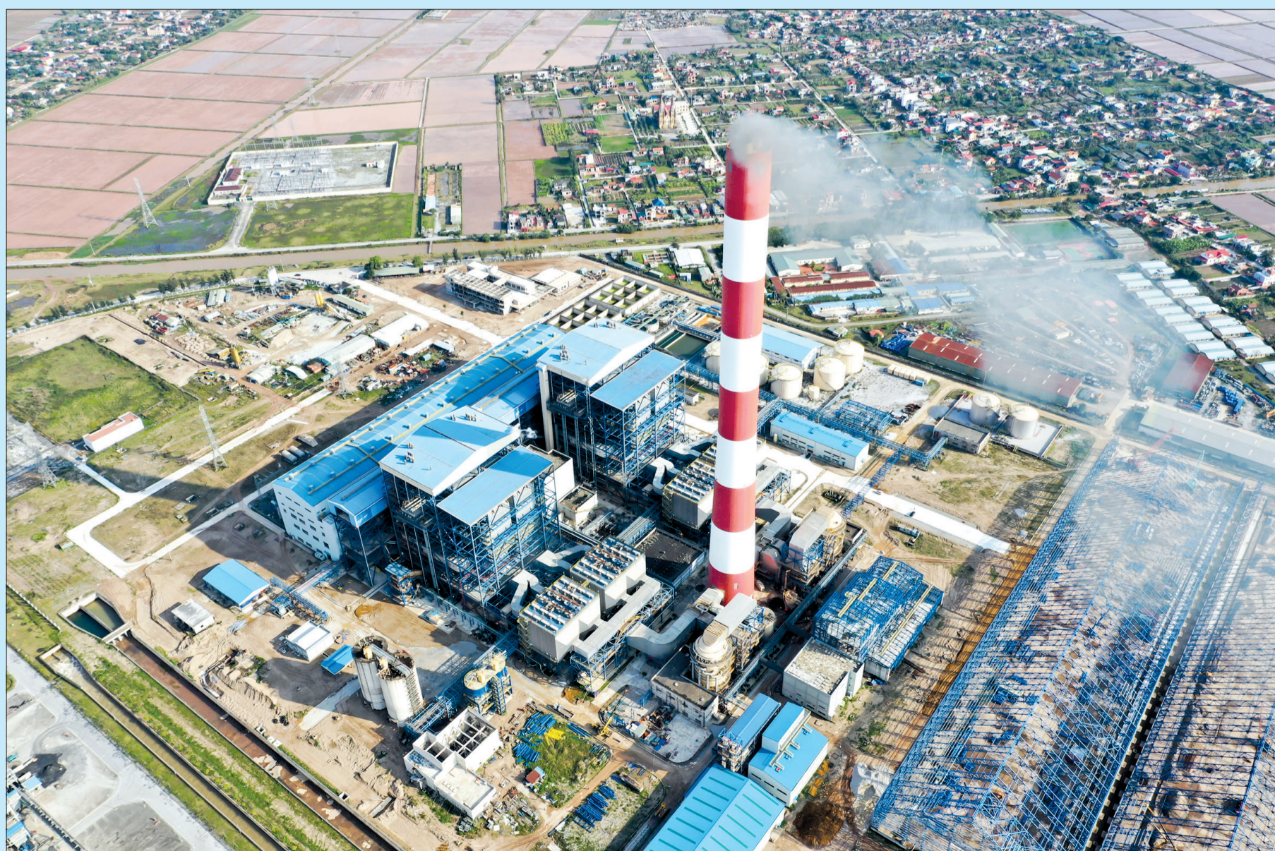
Nhà máy nhiệt điện Thái Bình 2.
