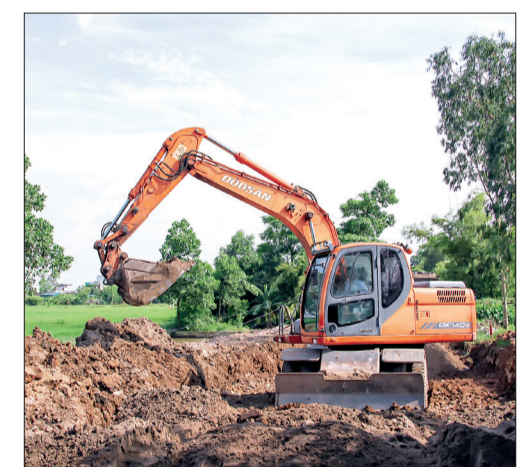
Thi công đường ĐH.12 kéo dài qua UBND xã Tự Tân (Vũ Thư).
