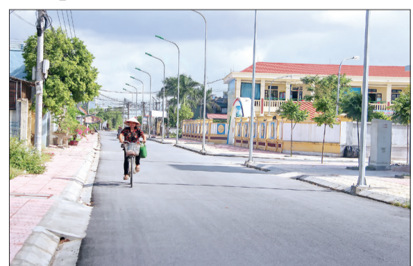
Đường giao thông nông thôn xã Tây Giang.
