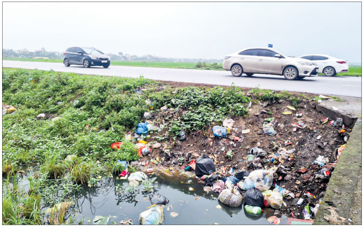
Người dân xã rác bừa bãi bên đường 39 ngay khu vực bãi rác xã Đông Hoàng (Đông Hưng).
