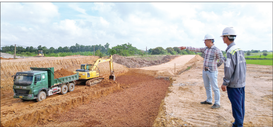
Thi công dỡ gia tải, xử lý nền đất yếu tại địa phận huyện Tiền Hải.
