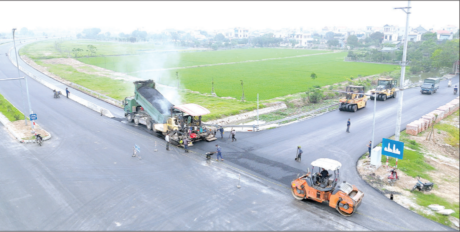
Thi công thảm bê tông nhựa tại nút giao với xã Trung An (Vũ Thư).
