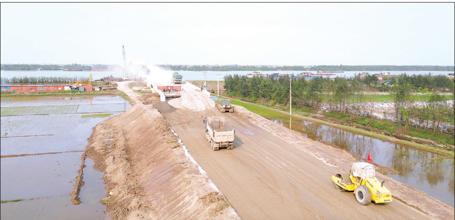
Thi công hoàn thiện phần nền đường chân cầu sông Hồng phía Nam Định.
