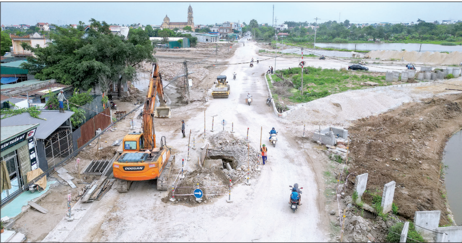
Đơn vị thi công khẩn trương xử lý nền đất yếu tại khu vực nút giao đường tỉnh ĐT.463 vừa được bàn giao mặt bằng.
