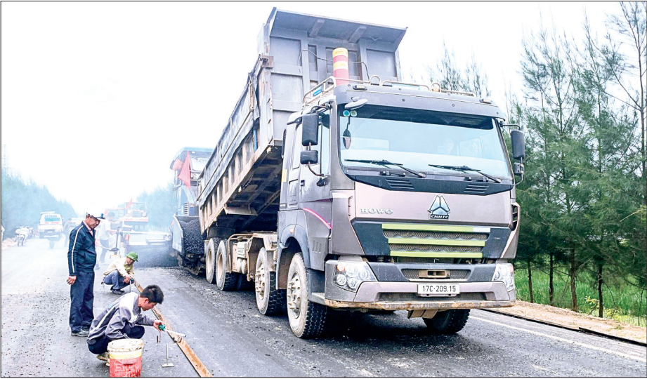
Thi công láng nhựa mặt đường địa phận huyện Thái Thụy.
