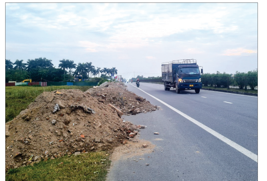
Rác thải xây dựng tại tuyến tránh S1 (thành phố Thái Bình).
