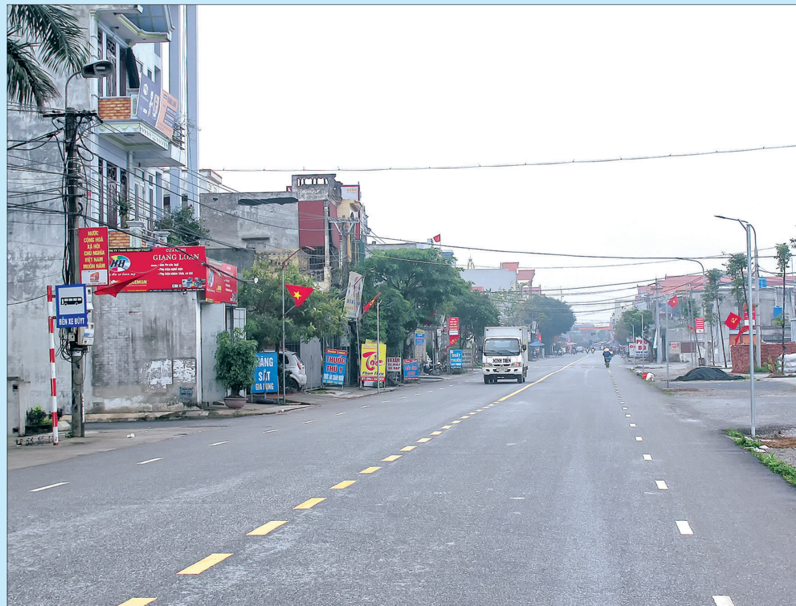
Cơ sở hạ tầng của xã Tây Giang (Tiên Hải) được đầu tư nâng cấp, hướng tới mục tiêu xây dựng nông thôn mới nâng cao.
