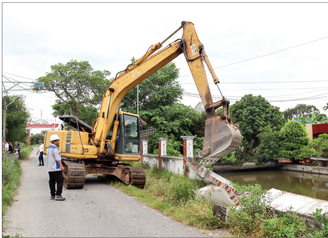
Công tác giải phóng mặt bằng ở hầu hết các dự án trên địa bàn huyện Kiến Xương đều được triển khai đúng tiến độ đề ra.
