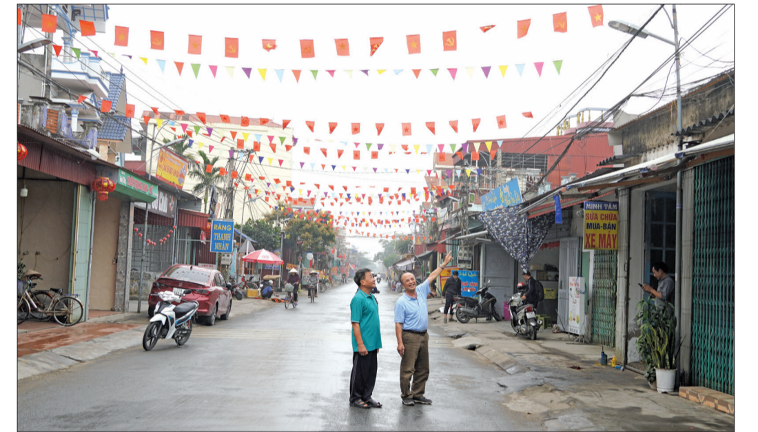
100% tuyến đường thôn 1 An Định, xã Thụy Văn (Thái Thụy) lắp đặt hệ thống điện chiếu sáng.
