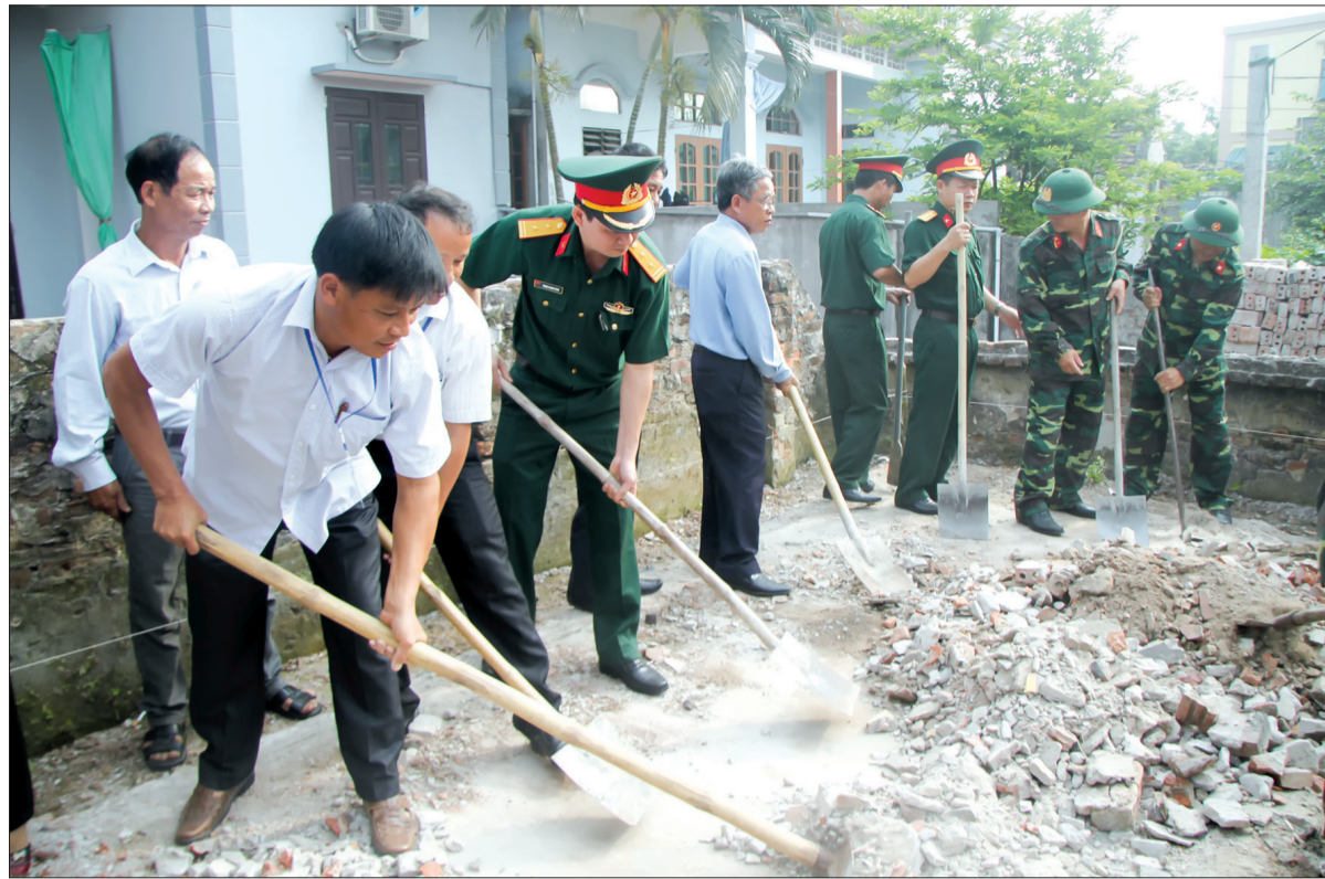
Ban Chỉ huy Quân sự huyện Kiến Xương phối hợp xây dựng nhà tình nghĩa tặng đối tượng chính sách.
