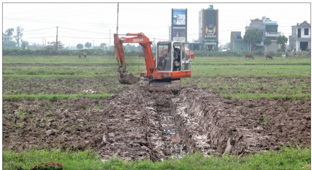
Kế hoạch làm thủy lợi đồng xuân năm 2018 - 2019 của các huyện, thành phố dự kiến đào đắp gần 2,8 triệu mét khối.
