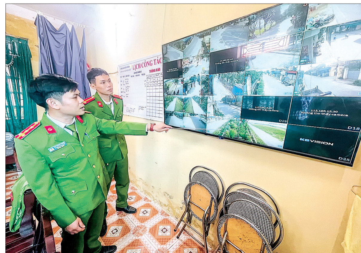
Công an xã Tiên Đức (Hưng Hà) lắp đặt 24 mắt camera giám sát tại 14 điểm phức tạp trên địa bàn.
