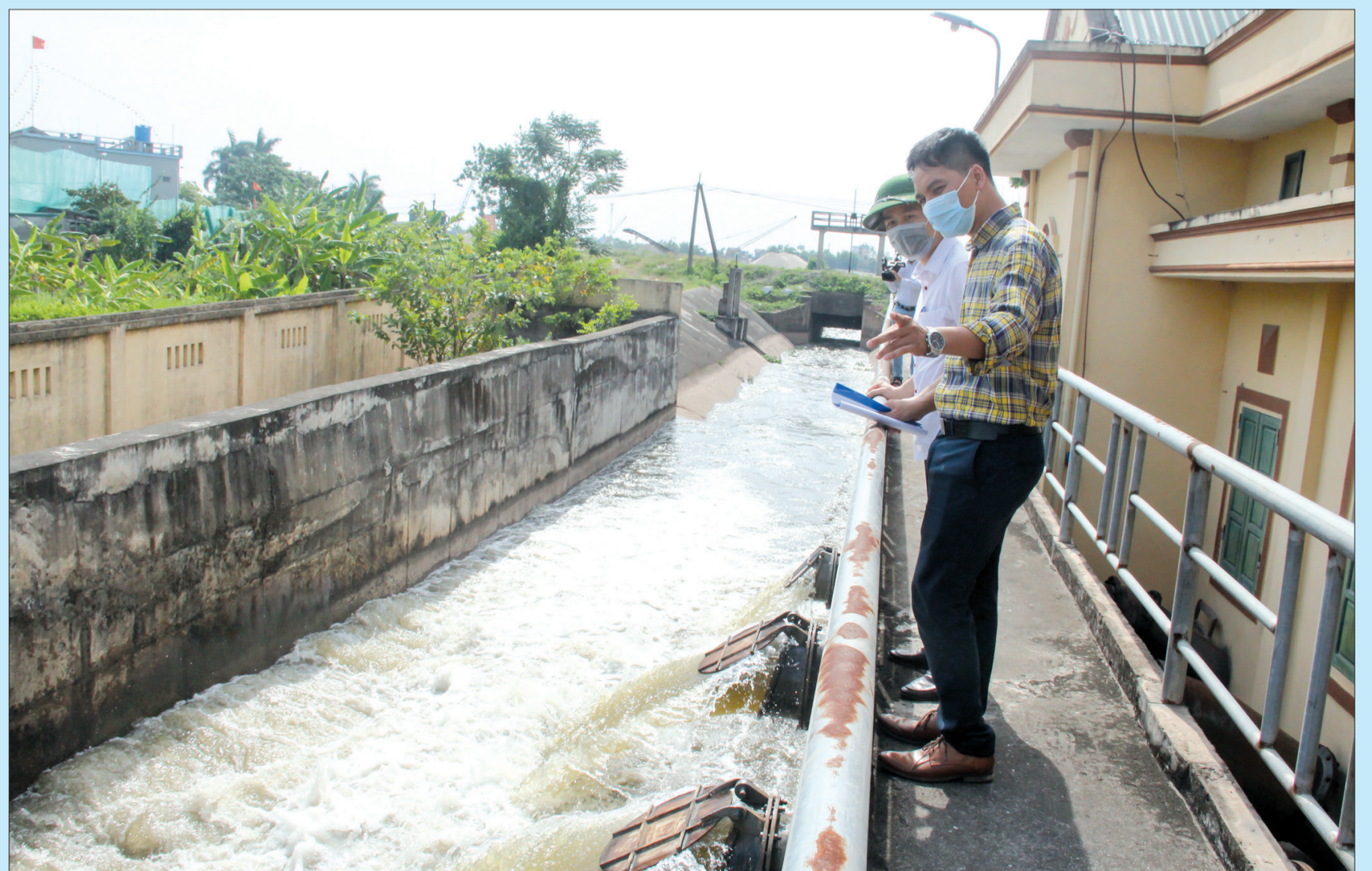
Công ty TNHH MTV Khai thác công trình thủy lợi Nam Thái Bình chạy thử bơm tiêu sẵn sàng vận hành tiêu úng khi có lệnh.
