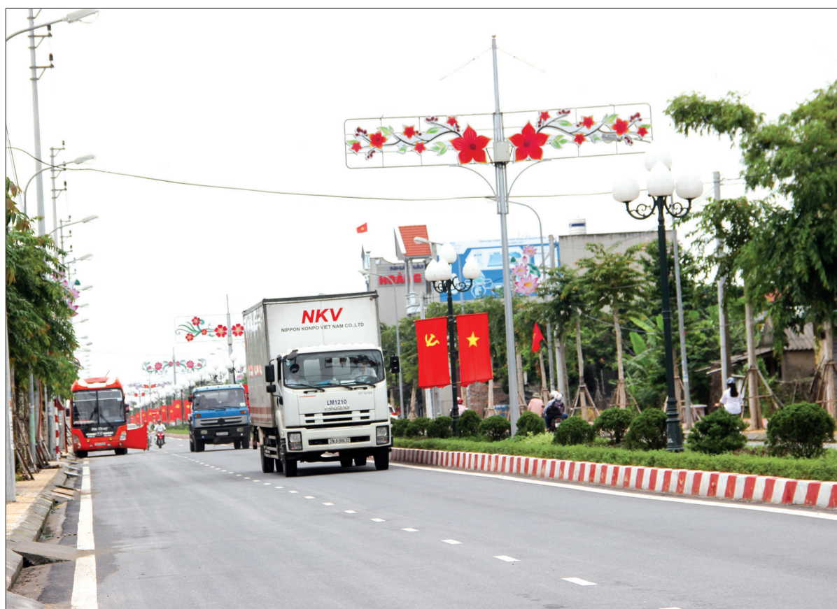
Hệ thống đèn trang trí được lắp đặt trên nhiều tuyến đường ở thành phố Thái Bình.
