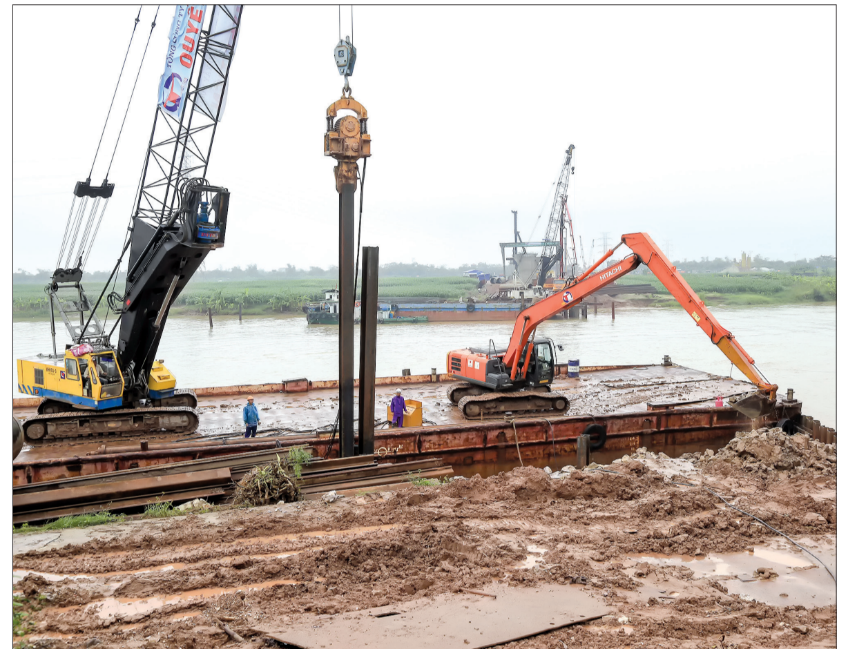
Cầu La Tiến (Hung Hà) đang được nhà thầu tập trung thi công.
