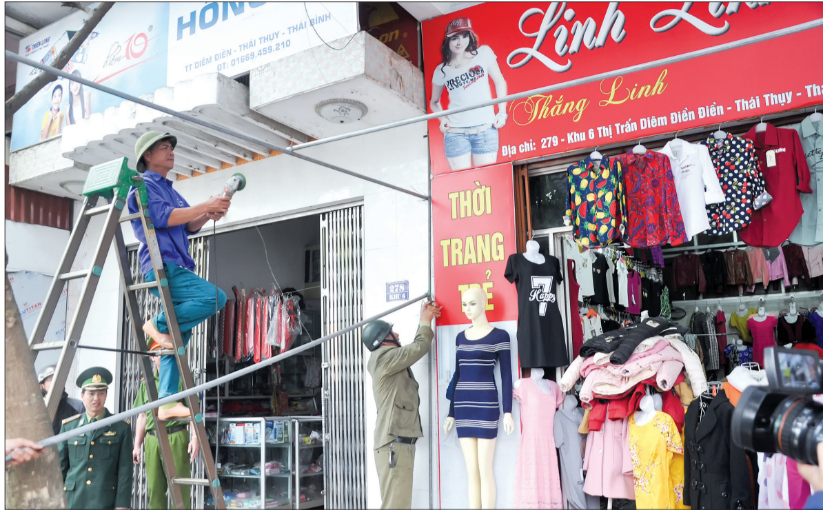
Lực lượng chức năng huyện Thái Thụy tháo dỡ biển quảng cáo vi phạm hành lang an toàn giao thông.
