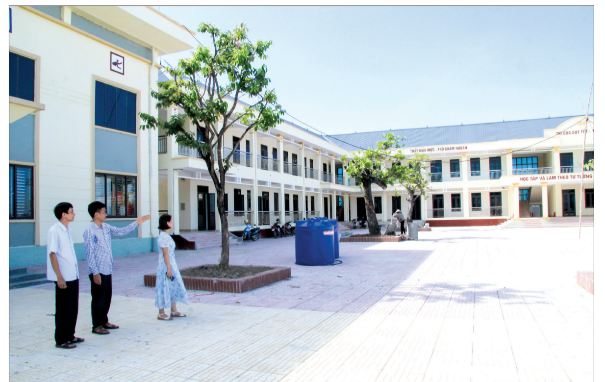
Trường Tiểu học và THCS Phúc Khánh (Hưng Hà) được đầu tư xây dựng khang trang.
