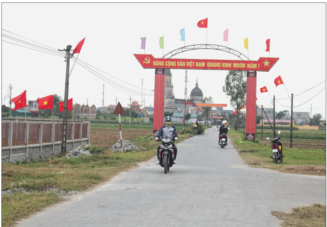
Đường giao thông nông thôn xã Thái Hưng.
