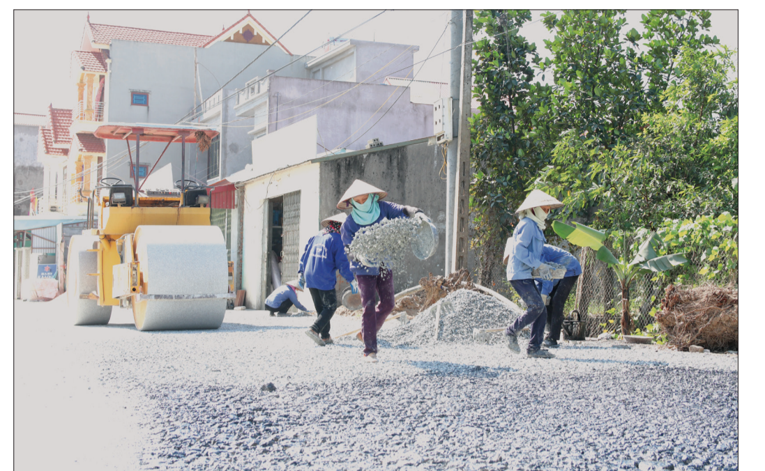
Thi công tuyến đường từ thành phố Thái Bình qua cầu Tịnh Xuyên đến huyện Hưng Hà, đoạn từ đường DH.09 đến đường tỉnh ĐT.453.
