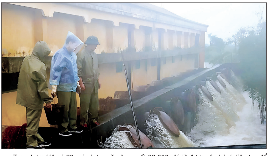
Trạm bơm Hệ có 22 máy bơm với công suất 88.000m³/giờ được vận hành liên tục để tiêu úng.
