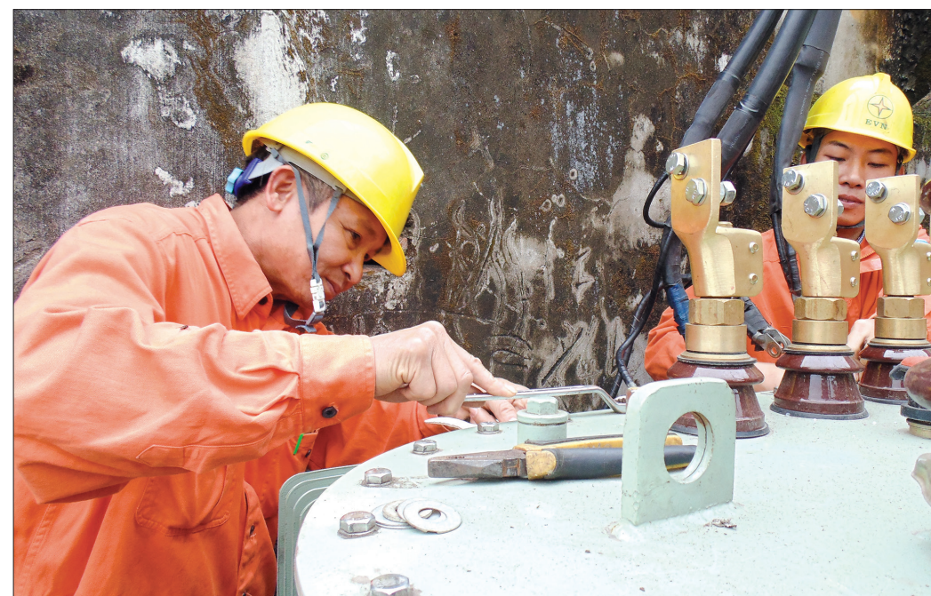
Công nhân Điện lực thành phố Thái Bình sửa chữa máy biến áp tại xã Phú Xuân.
