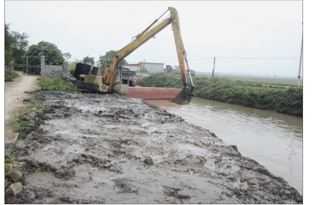
Xã Minh Khai (Vũ Thư) tiến hành nạo vét tuyến kênh dẫn nhằm tạo thuận lợi cho việc tiêu thoát nước nội đồng khi mưa lớn xảy ra.
