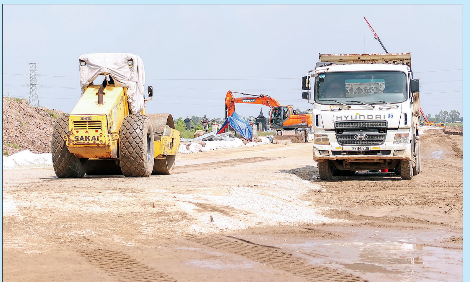
Thi công dự án tuyến đường bộ ven biển tỉnh Thái Bình tại nút giao với quốc lộ 39.
