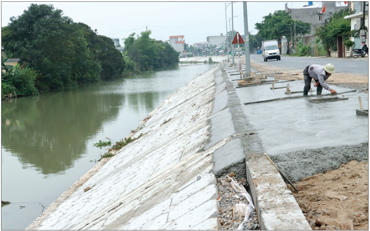
Kê Liên Hoa được đầu tư xây mới đang gấp rút hoàn thiện.
