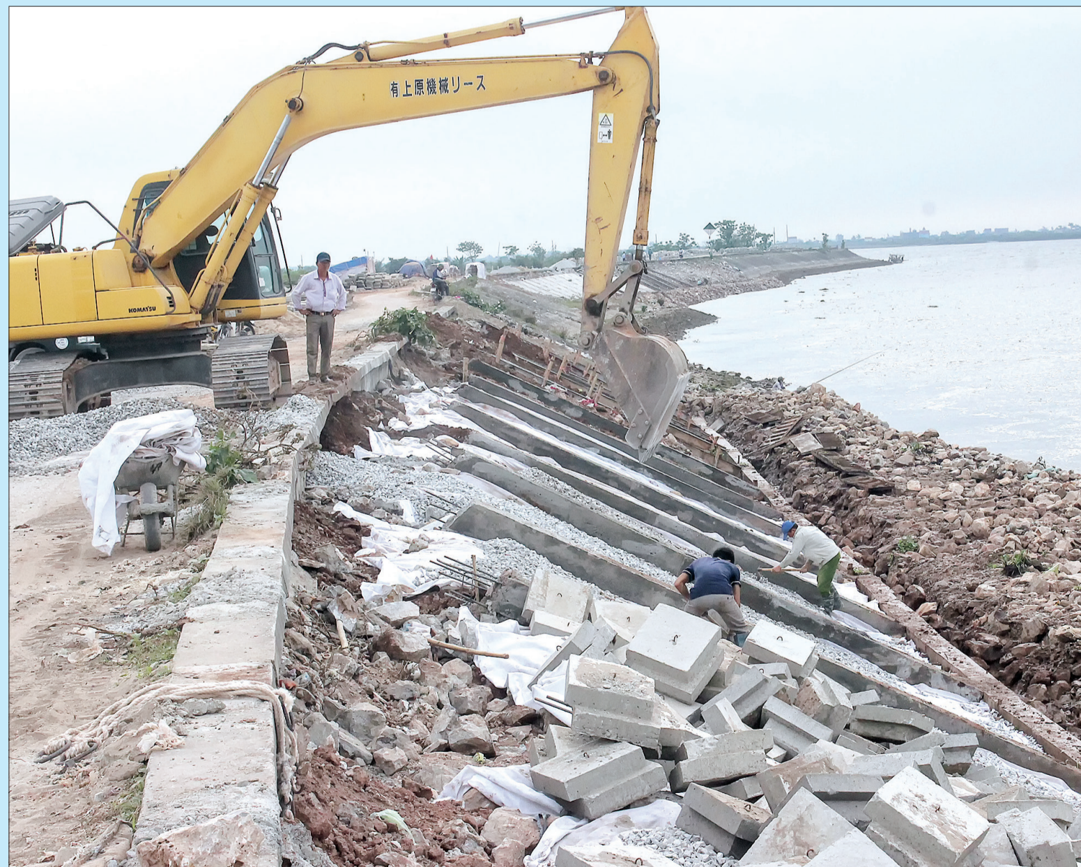
Các tuyến đê biển, đê sông của Tiền Hải hàng năm được đầu tư củng cố.
