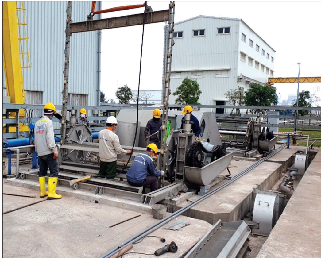
Nhóm kỹ sư trẻ tập trung sửa chữa, căn chỉnh lưới quay rác hệ thống nước làm mát chính của Nhà máy nhiệt điện Thái Bình 2.
